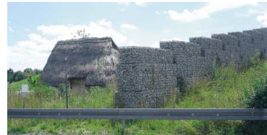
Abb. 72: Sinnvolle Kombination: Lärmschutzwall mit aufgesetzter Wand
