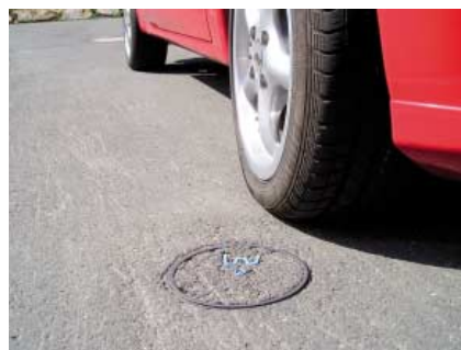
Abb. 33: Konische Schachtabdeckungen mit Asphaltoberfläche verringern den Straßenverkehrslärm
