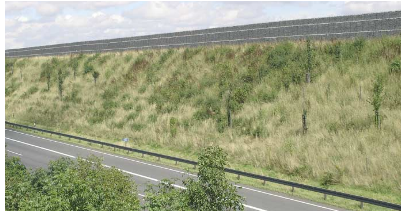
Abb. 70: Oft zu sehen: Wall und aufgesetzte Wand
