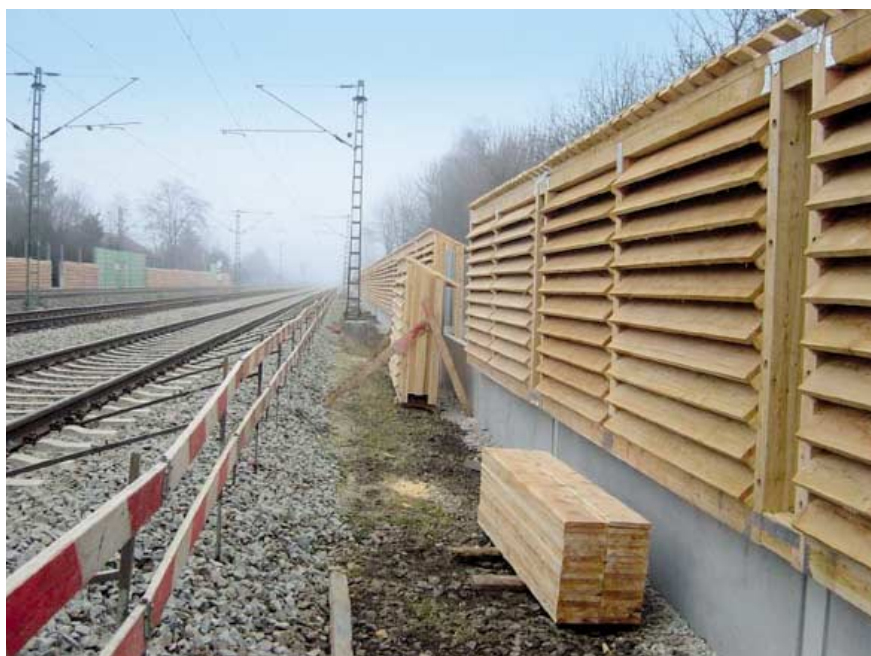
Abb. 67: Die Lärmschutzwand aus Holz und Stroh – naturnah und wirkungsvoll
